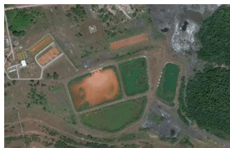
Рисунок 2 – Площадка очистных сооружений шахты «Глубокая»
